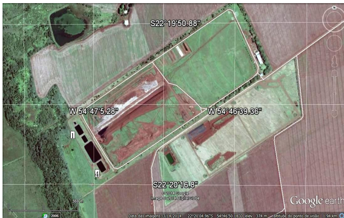
Figura 1. Vista aérea do aterro sanitário de Dourados, MS, Brasil. O reservatório menor é o tanque de homogeneização, na sequência têm-se as quatro lagoas de tratamento.
