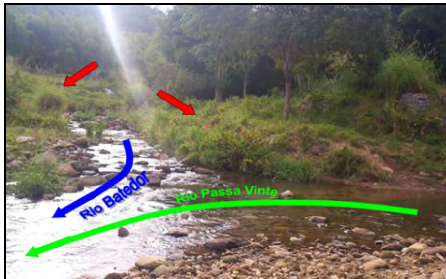
Figura 11. Foz do rio Batedor, afluente do Rio Passa Vinte.
